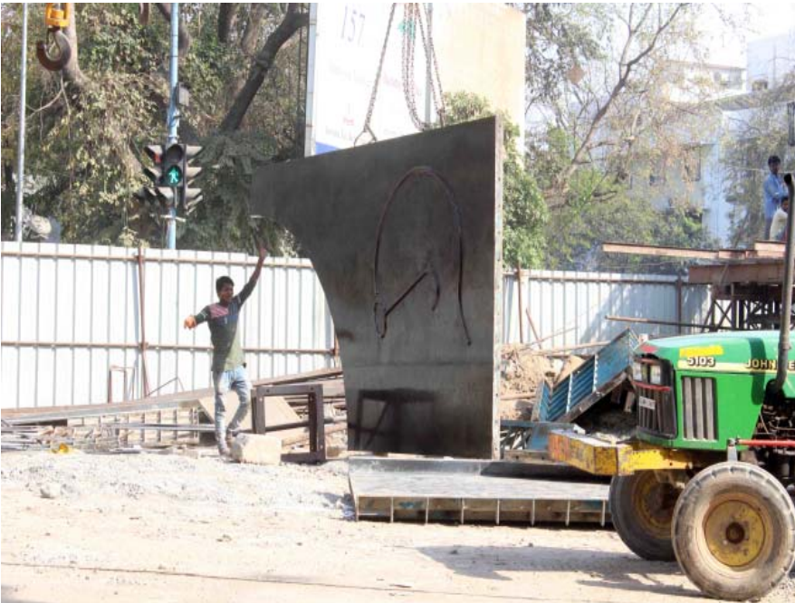
इन्कटेक्स के निकट पुल का निर्माण काम चल रहा है।
