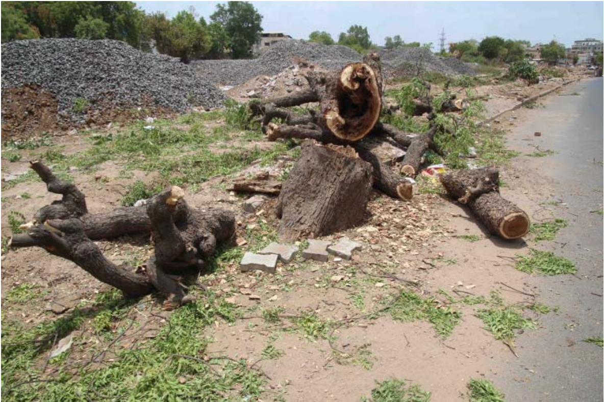
अहमदाबाद में मेट्रो रेल का काम चल रहा है जिसकी वजह से कई पेड़ काटे जा रहे हैं।
