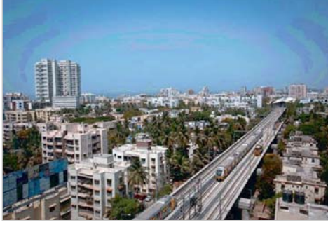
बेंगलुरु मेट्रो रेल परियोजना के चरण दो के लिए 52.03 अरब येन और दिल्ली मेट्रो के चौथे चरण के लिए 119.97 अरब येन का ऋण उपलब्ध कराया जाएगा।
